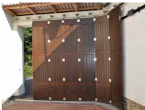
Posuvná dřevěná vrata jako vjezd do dvoru.
